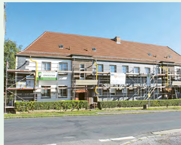
Die Wohnungen in der Georgenstraße sind sehr beliebt. Aktuell bekommen die Eingänge 31/32 eine neue Fassadendämmung und werden energetisch saniert.
