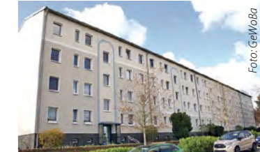
Wie neu – nach der Fassadenreinigung sieht das Haus in der Heinrichstraße aus wie frisch gestrichen.
