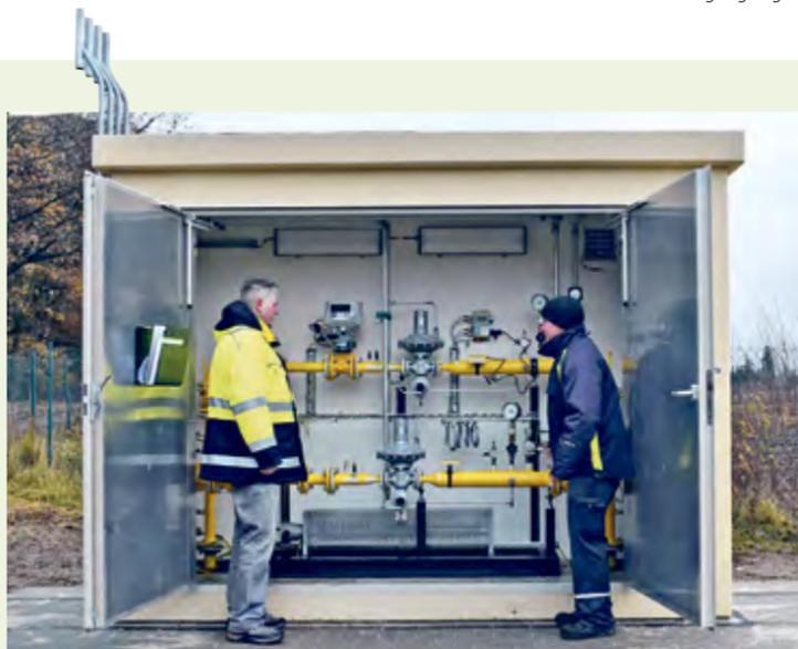
für den Endverbraucher auf wenige Millibar runtergeregt. Neben der Druckreduzierung messen und filtern die Anlagen die strömende Gasmenge und schützen die Anlagenteile vor zu hohem Druck oder gegen Gasmangel. Außerdem registrieren sie wichtige Kenngrößen wie Gasmenge, Gasdruck und Betriebszustand des Gases.
